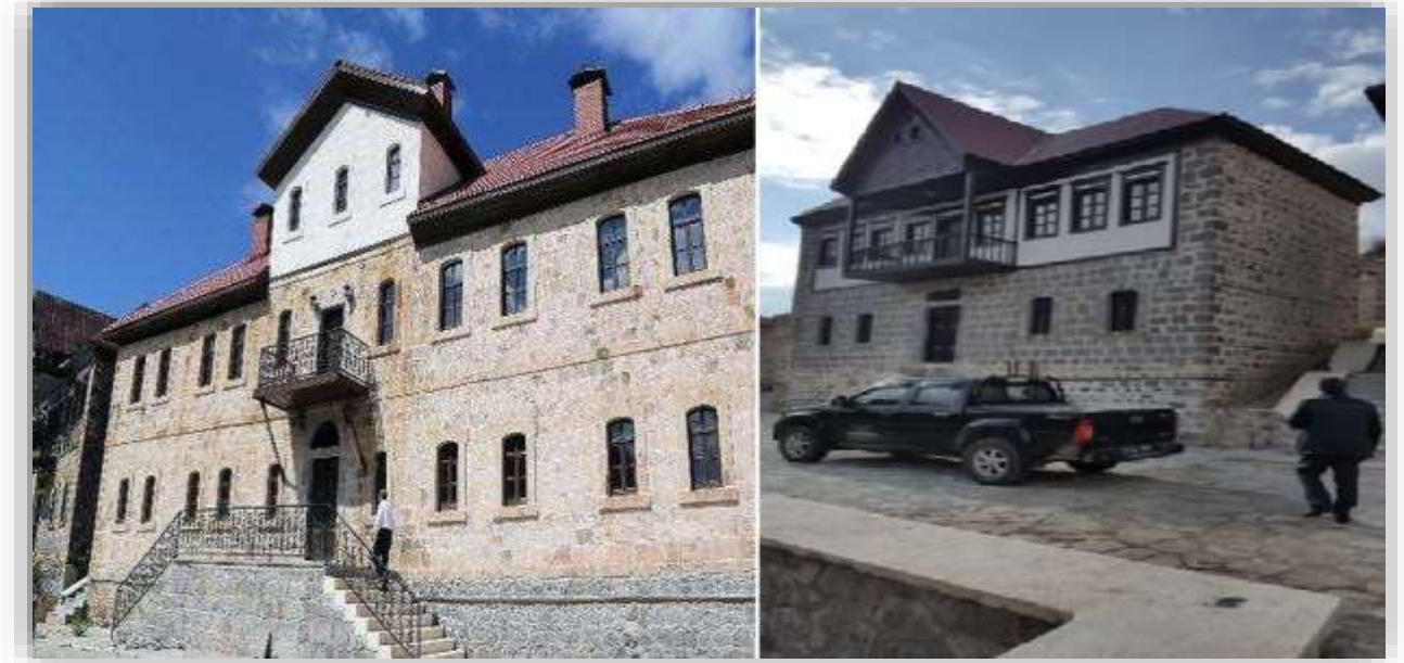
Yeşildere Köy Konağı ve Ek Binası
