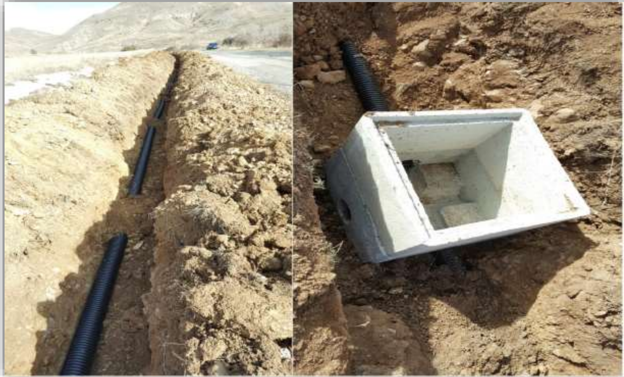
Köse İlçesi, Oylumdere Köyü Kanalizasyon Hattı Yapım İş
