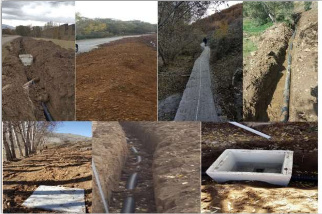
Kelkit İlçesi, Aşut, Deliler, Başpınar ve Yeni Yol Köyleri Kanalizasyon Hattı Yapım Projesi
