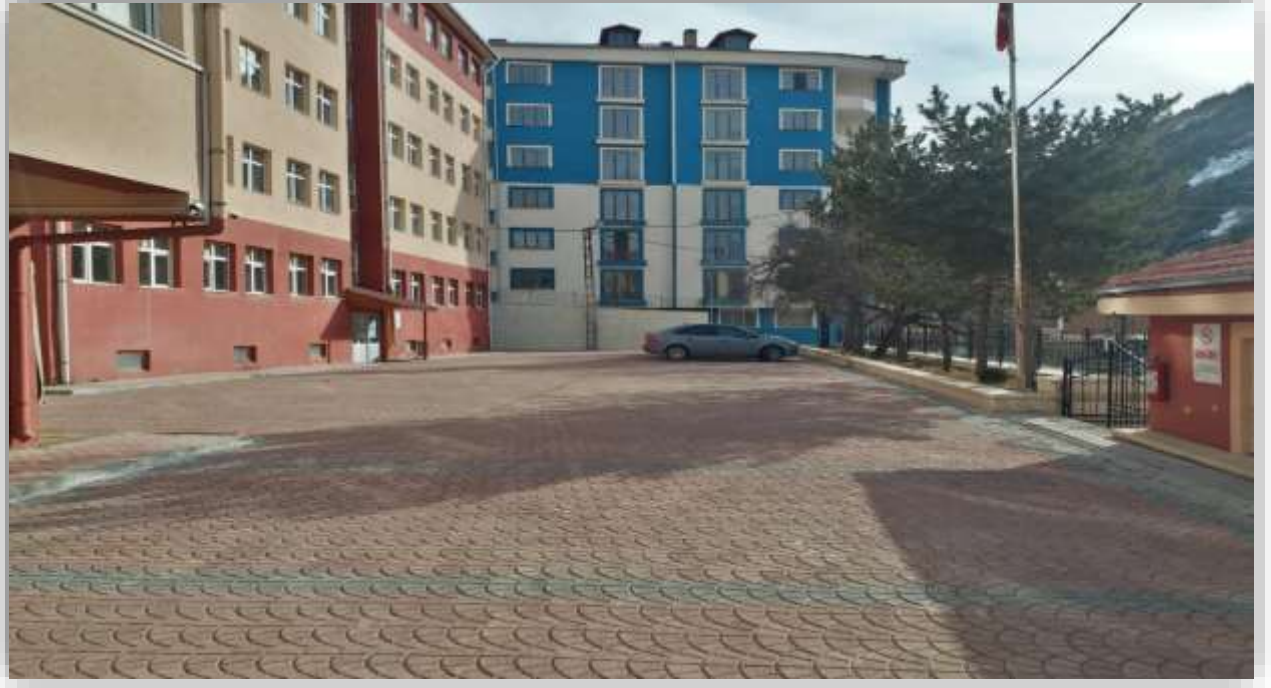
Gümüşhane İl Özel İdaresi Bina Önü Dekoratif Parke Kaplama Ferforje Demir Kapı Ve Korkuluk Yapım İşi
