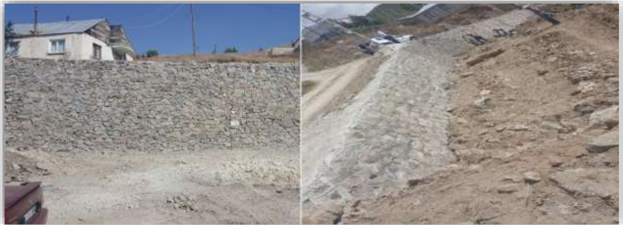
Merkez İlçe, Arduç Köyü Taş Duvar Yapım İşi
