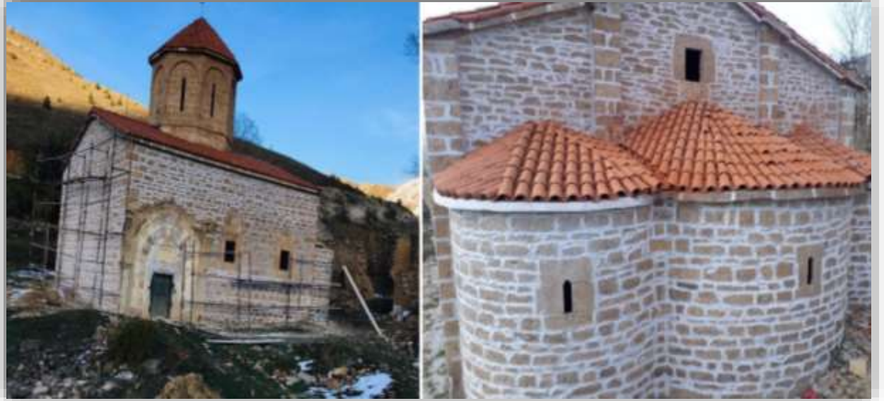
İmera Manastırı Çatı Onarımı İşi
