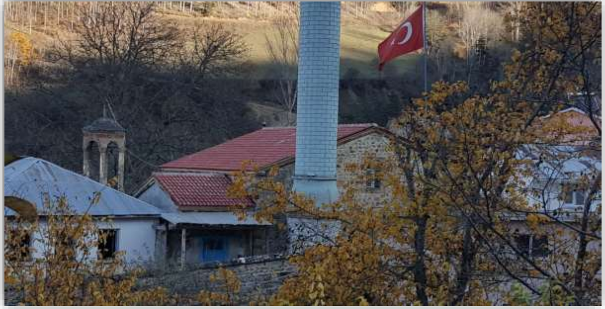
Torul Arpalı Köyü Cami Çatı Onarımı
