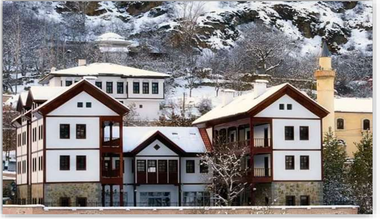
Merkez İlçe, Süleymaniye Kültür Kompleksi Yapım İşi
