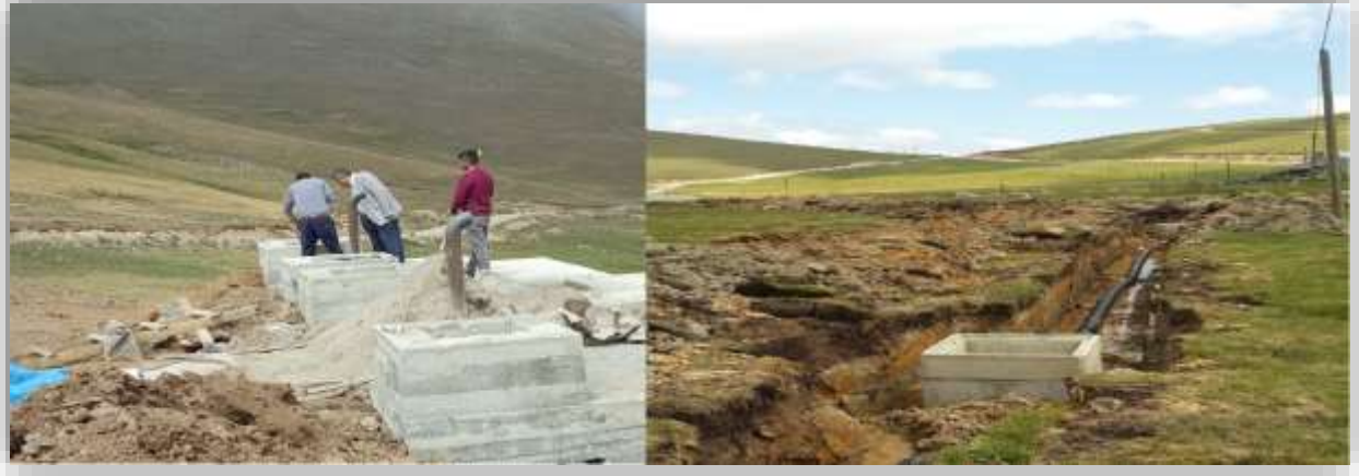
Kürtün İlçesi, Söğüteli Köyü Kanalizasyon Hattı ve Foseptik Yapım İşi
