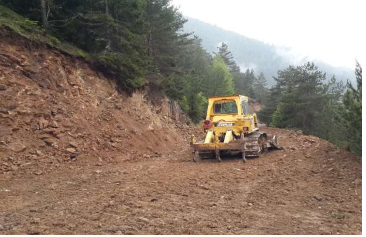
Merkez Yitirmez Bal Orman Yolu Yol Yapım Çalışmaları
